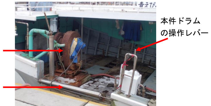
写真1 前部甲板の左舷側の状況
