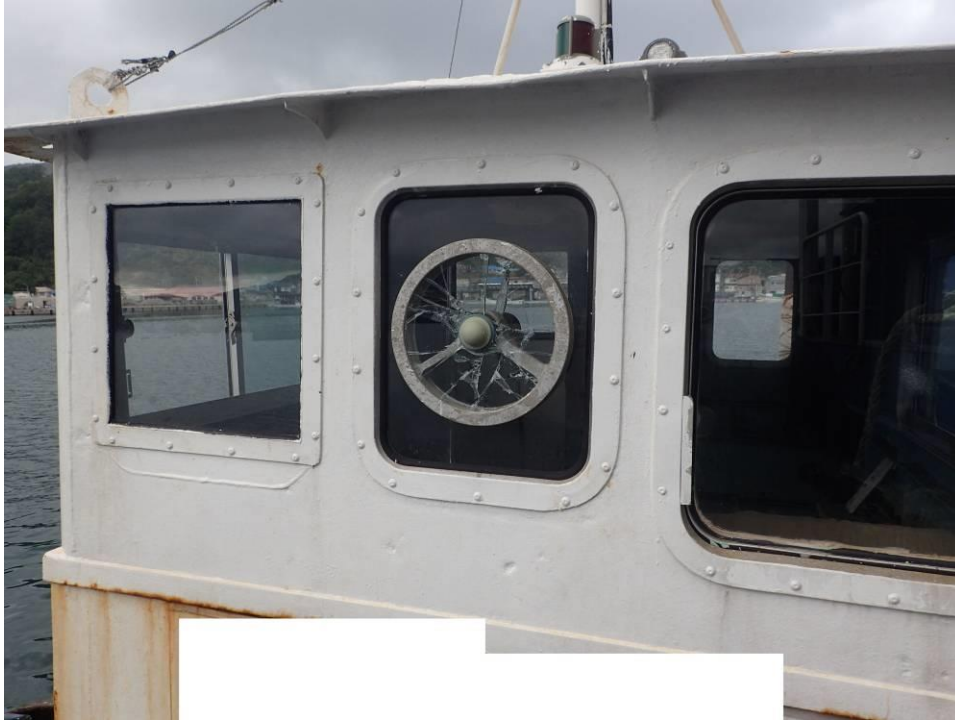
写真3 破損した旋回窓
