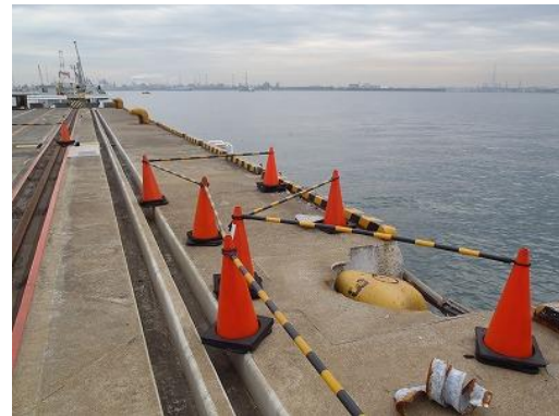
写真4 ビットの陥没状況
