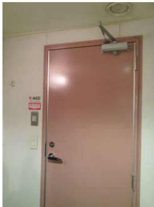
写真 2.5-2 旅客室の出入口ドアの状況
