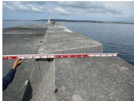
写真 2.4-3 パラペットの移動状況
