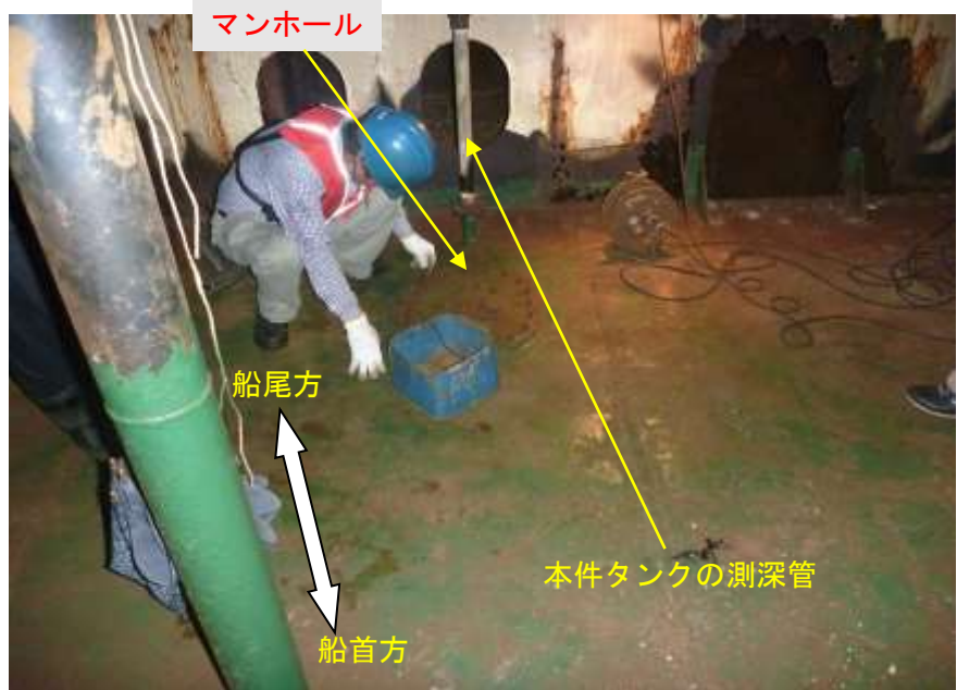
写真1 マンホール付近の状況
