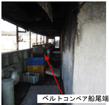
写真1 左舷通路船尾側 (船尾側から)
