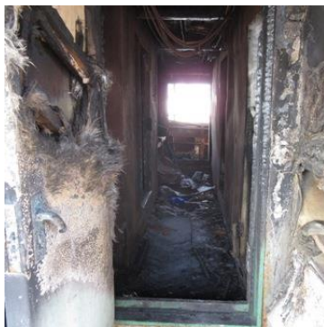
写真7 横通路 (右舷側から)
