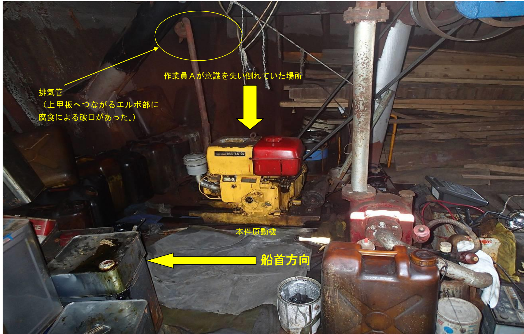
写真1 機関室内の状況
