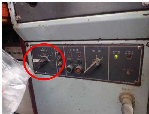
写真2.5 操舵スタンド下部の操舵切替つまみ
