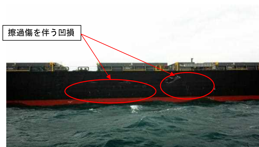
写真 1 A船右舷中央部損傷状況
