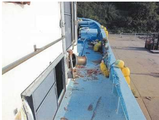
写真5 B船右舷に破損
