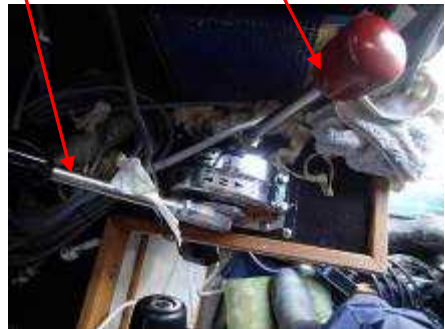
写真8 機関操縦レバー
