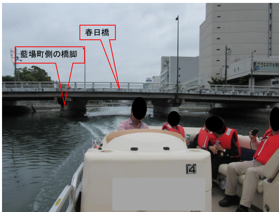
写真5 上流からの春日橋方向の見通し状況
