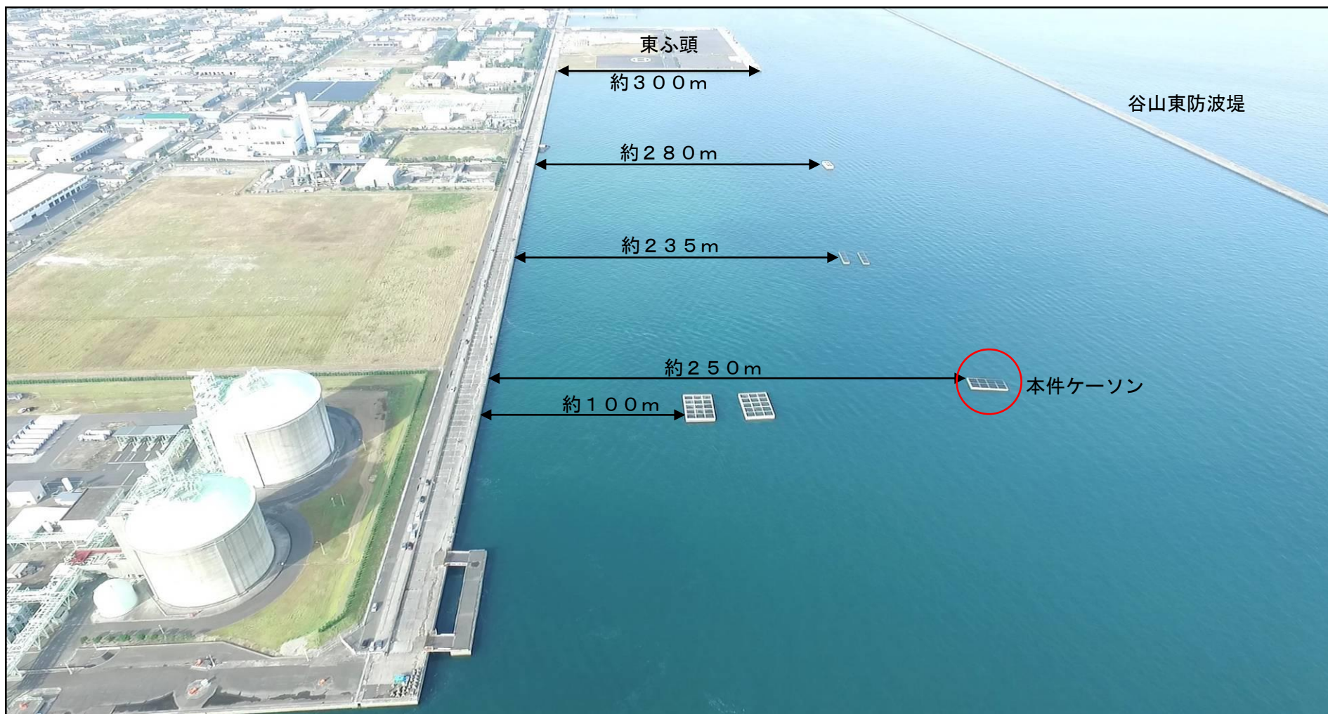
写真1 ケーソン仮置き場の南方上空から見たケーソン仮置き状況
