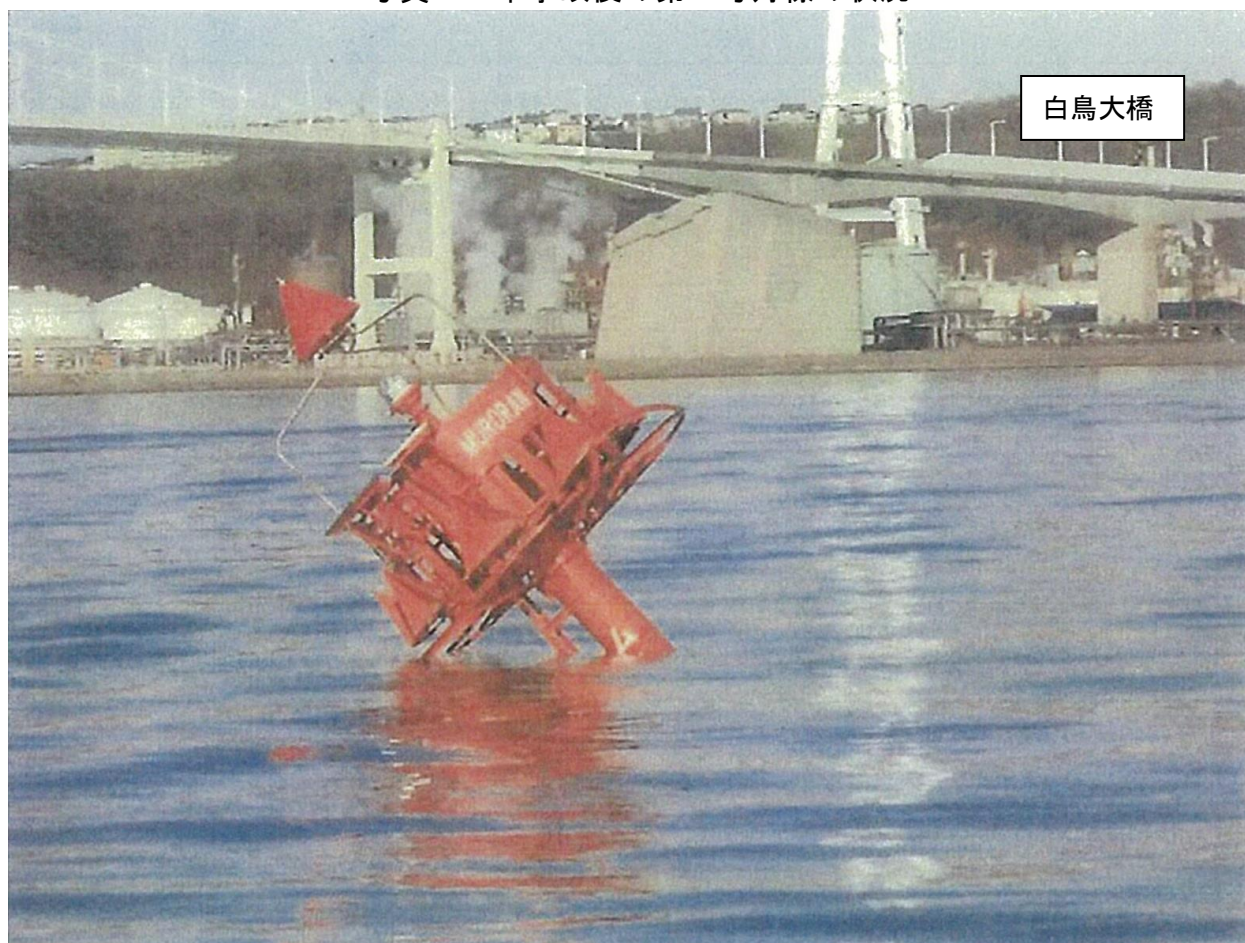
写真1 本事故後の第2号灯標の状況
