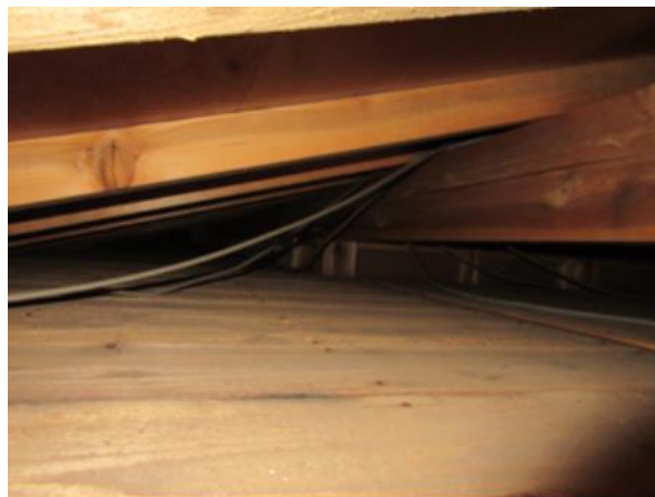
写真6 左舷側通路天井裏
