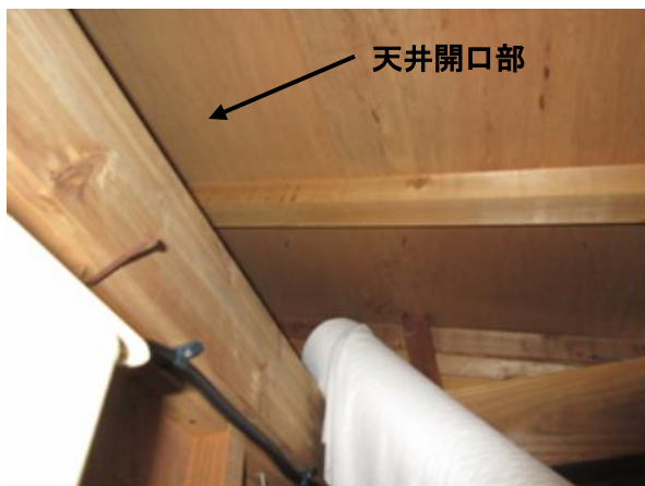
写真5 本件倉庫天井
