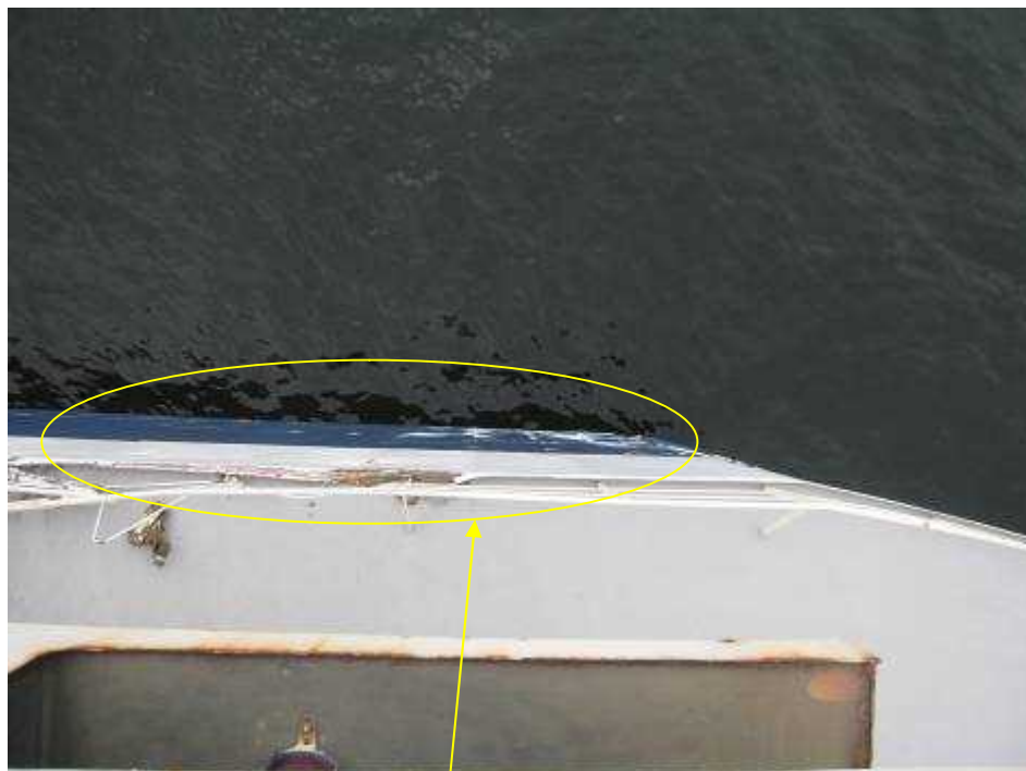
凹損及び擦過傷
