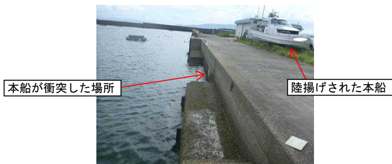
写真1 本件岸壁付近の状況
