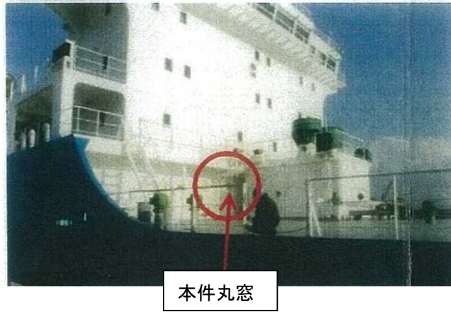
写真1 本件丸窓の位置
