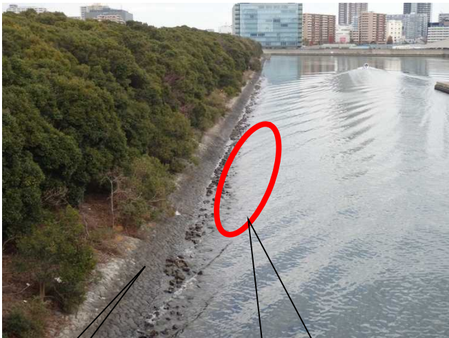
写真1 事故発生場所（本件防波堤） (潮高 約1.0m (東京港))
