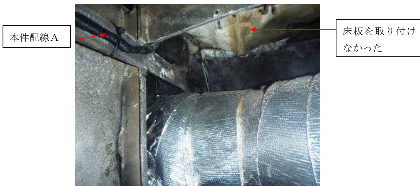
写真5.1 焼損箇所の修復状況
