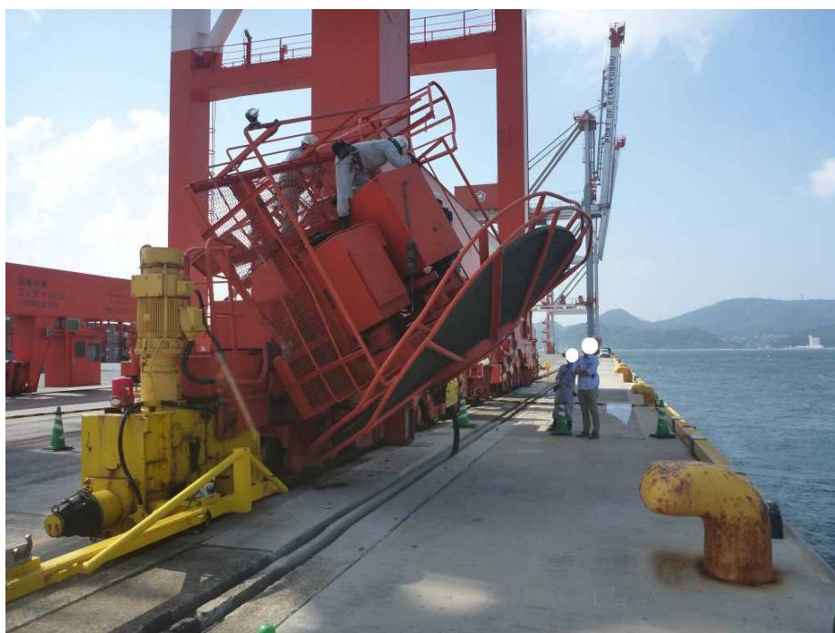
写真2 ガントリークレーン損傷状況（ケーブルリール脱落）
