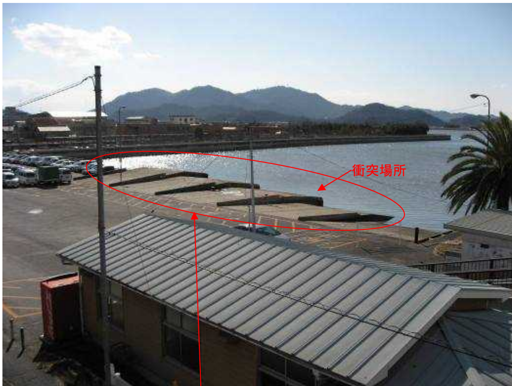
本件物揚岸壁
