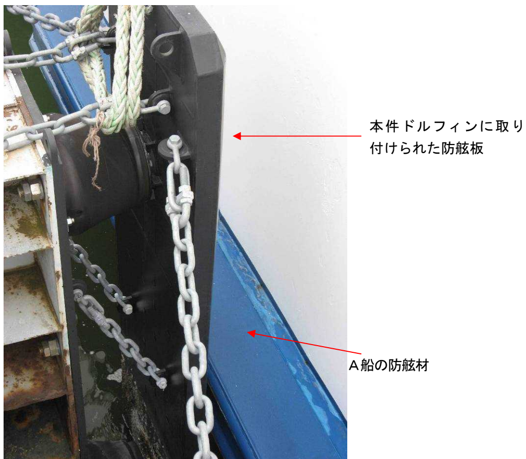
写真6 本件ドルフィンに取り付けられた防舷板の状況
