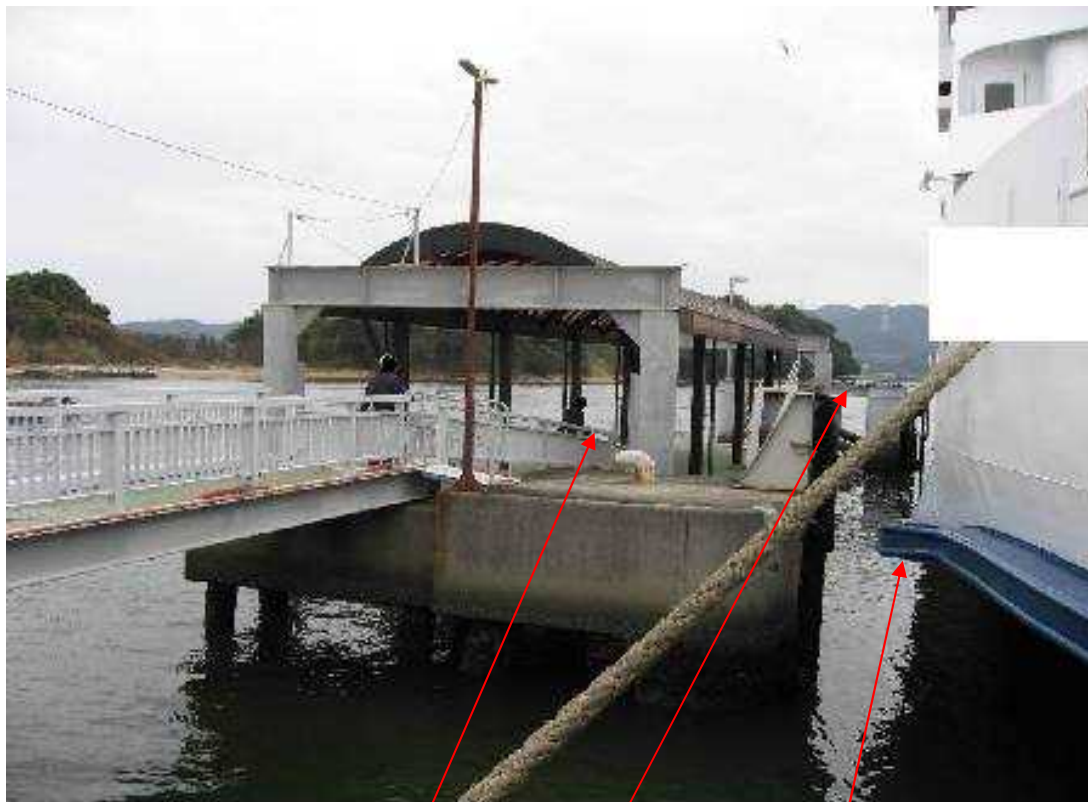
本件棧橋 本件ドルフィン A船の防舷材
