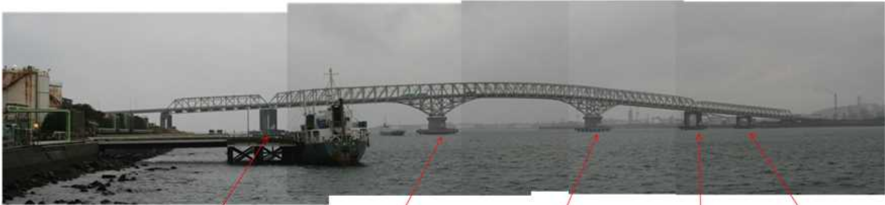
写真1 沖の山石炭第1出荷棧橋から興産大橋を臨む
