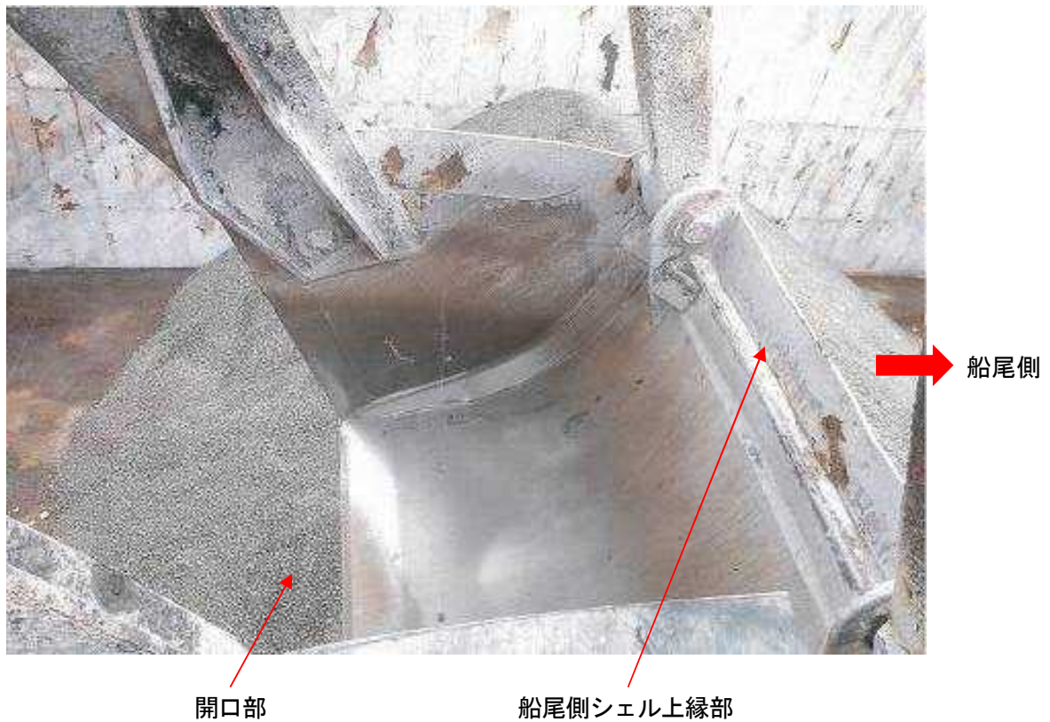
写真2 本件バケット船尾側シェルの状況
