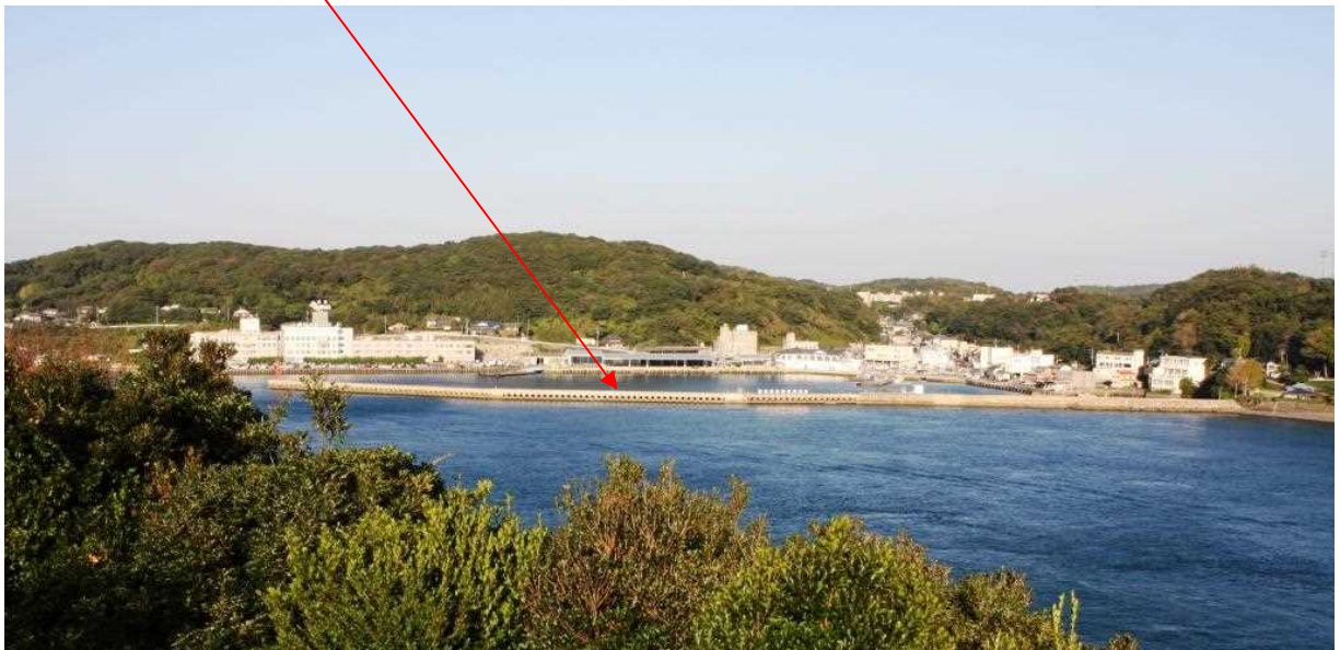
写真1 本件防波堤の状況
