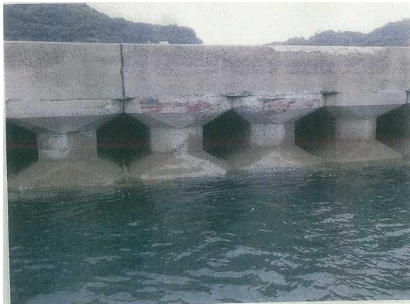
写真3 本件防波堤の損傷状況①
