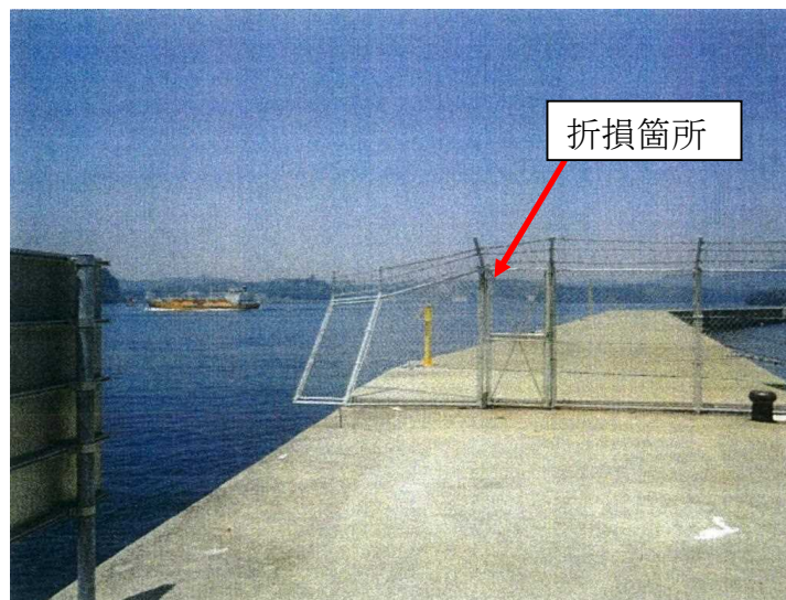
写真7 本件防波堤の損傷状況③
