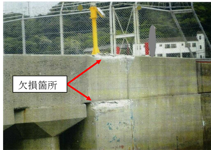
写真7 本件防波堤の損傷状況③
