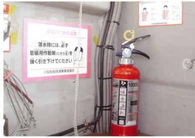
写真5 操舵室の粉末消火器 写真6 機関室遠隔温度計
