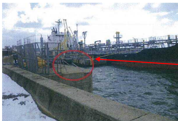
写真8 栈橋ハンドレール
