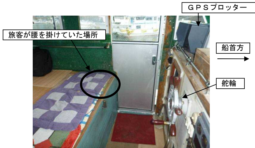
写真1 操舵室内の状況
