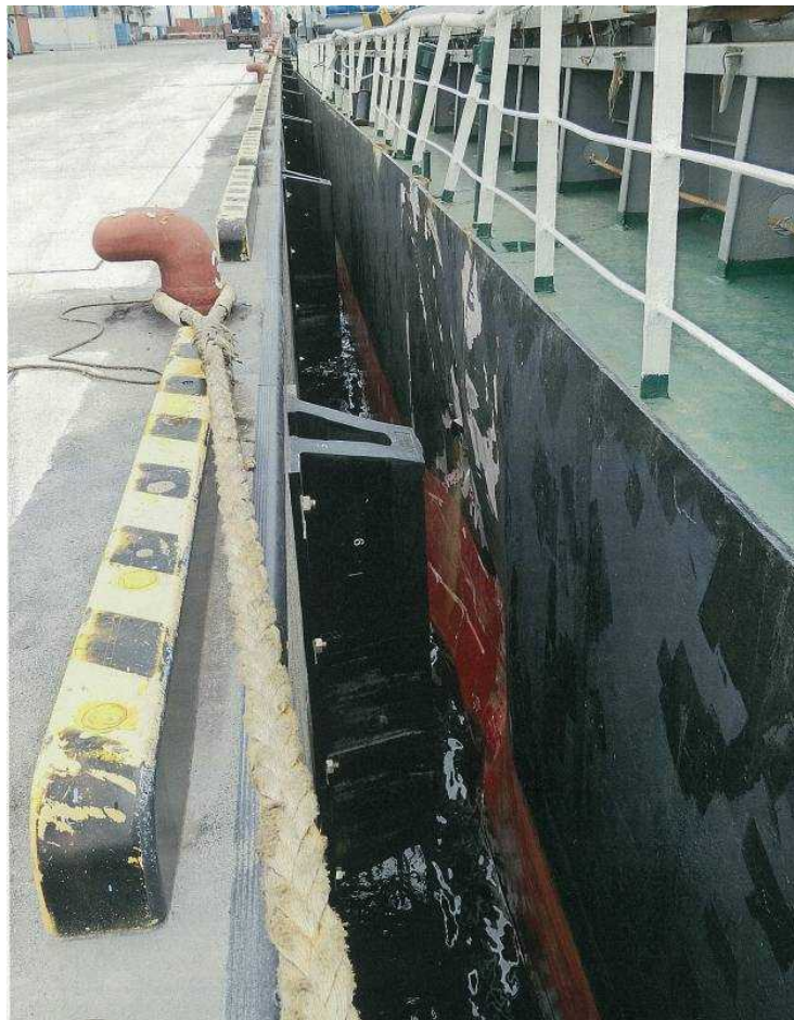
写真2 A船の損傷写真2
