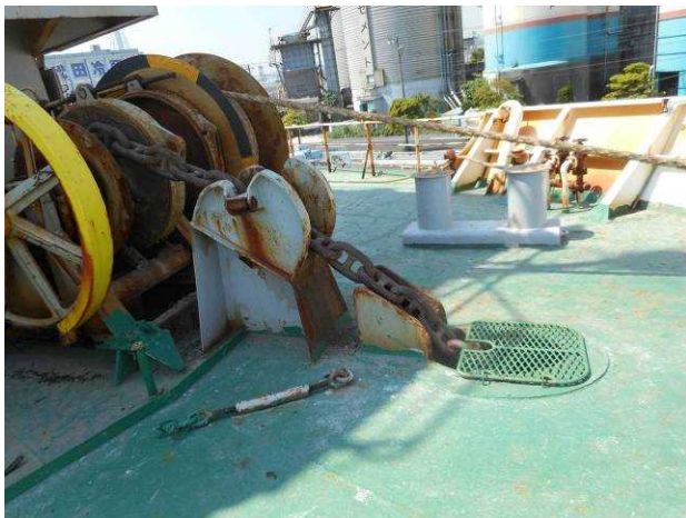
写真1 揚錨機付近の状況
