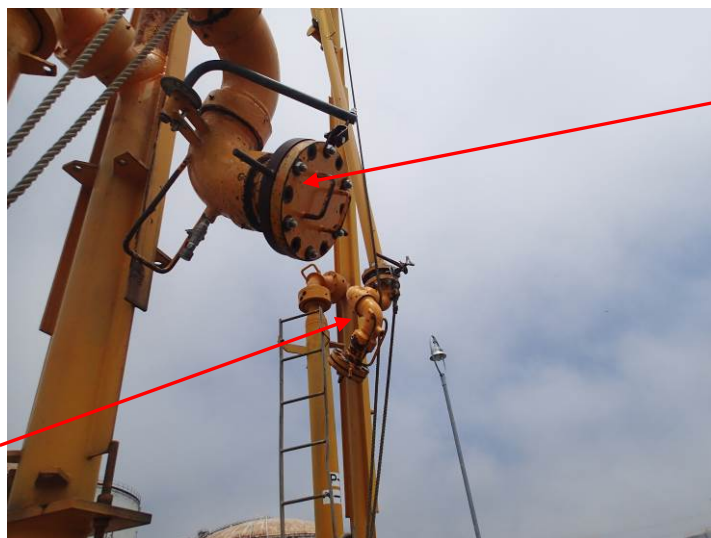
写真4 ローディングアーム先端部
