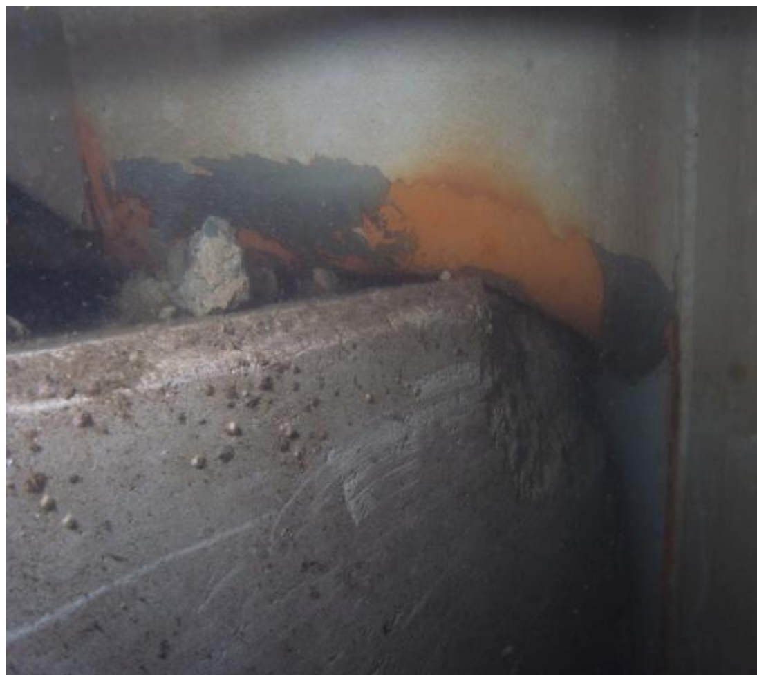
写真4 右舷船首部破口①及び コンクリートブロック
