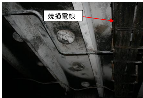
写真6 本件車両真上の天井焼損状況
