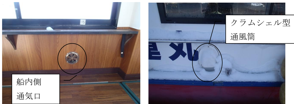
写真8 船内側通気口及びクラムシェル型通風筒の状況
