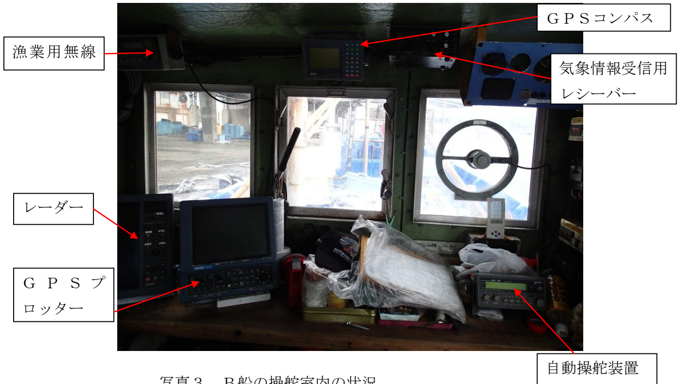
写真3 B船の操舵室内の状況
