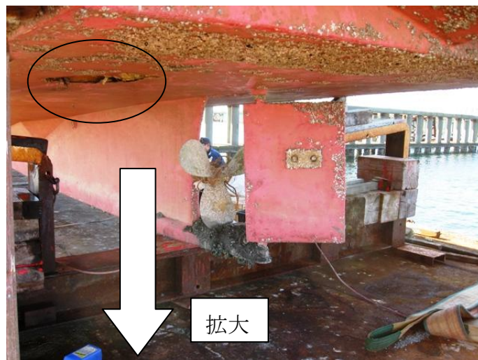
写真4 左舷船尾方から見た船底外板の状況
