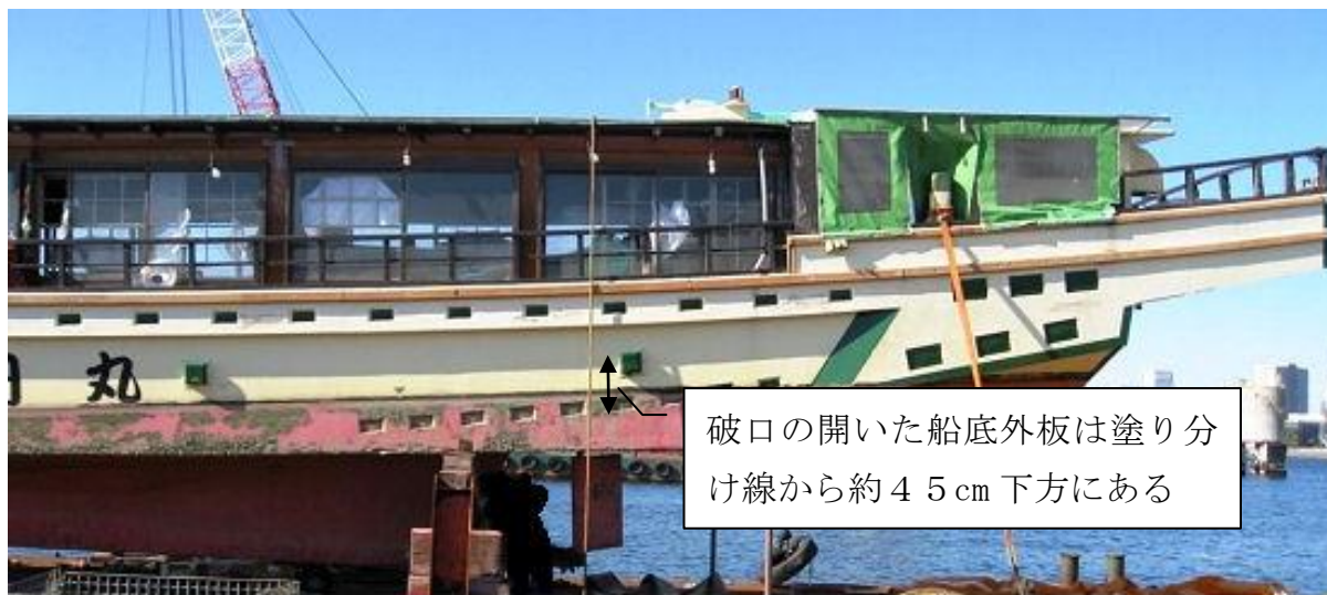
写真5 船側外板の塗装塗り分け線と水あか等の付着状況
