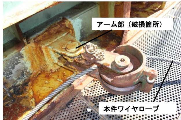
写真1 本件滑車の状況（修繕後）
