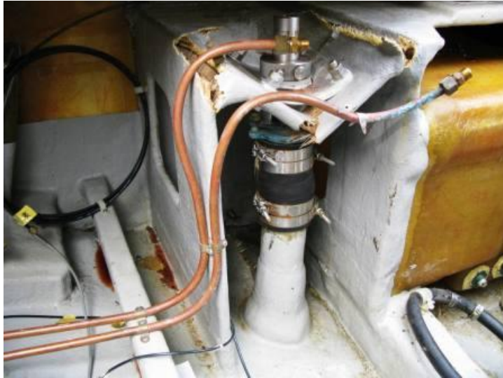
写真4 舵（右舷）の舵軸頂部の状況
