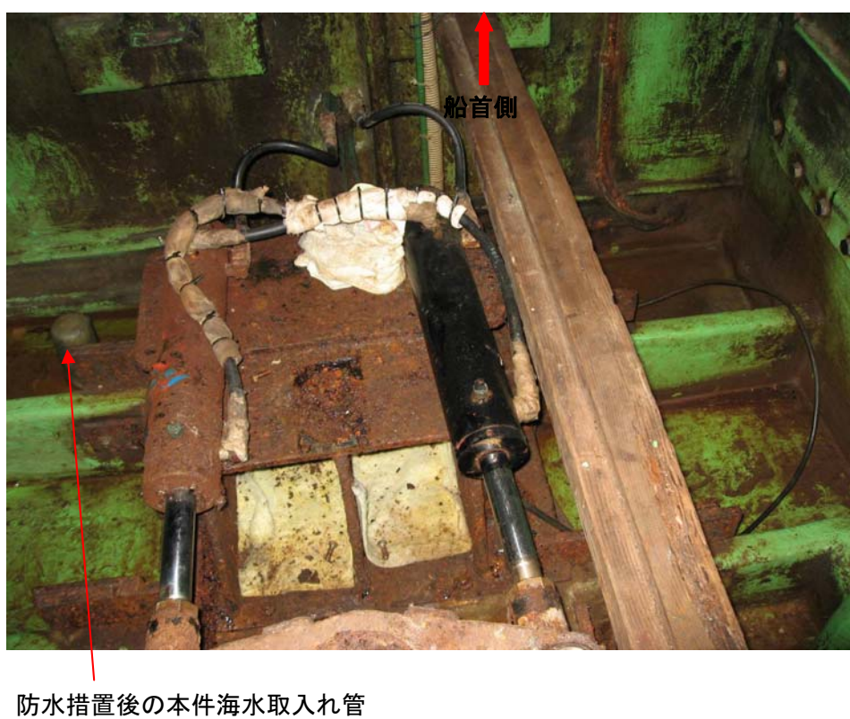
写真2 操舵機室内の状況
