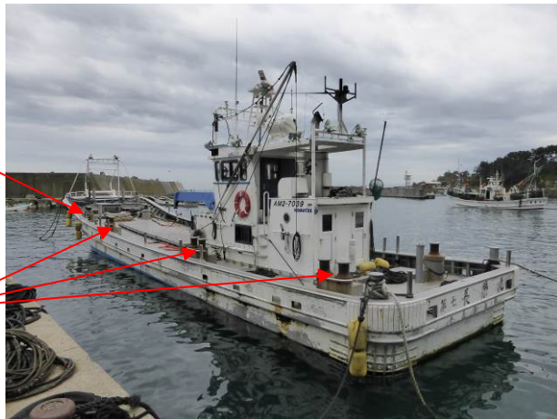
写真1 キャプスタン設置状況
