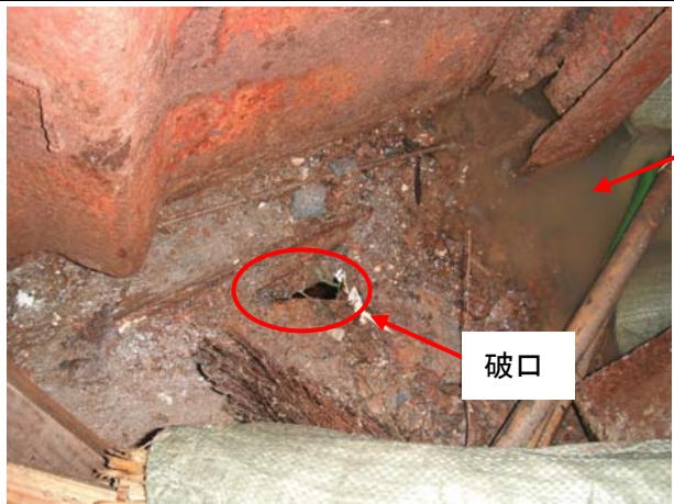
写真9 資材置場床面の破口
