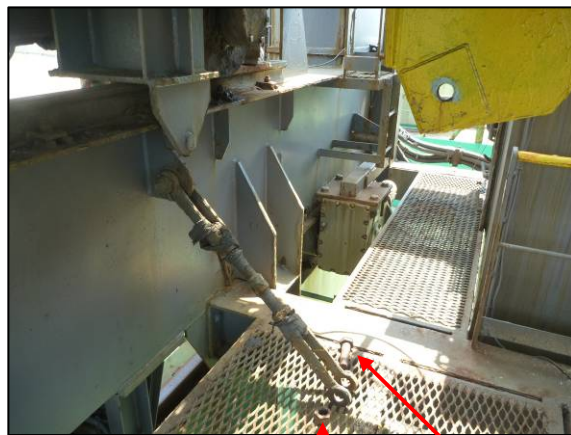
写真5 荷揚げ作業中の状態
