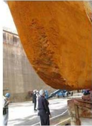
写真2 艦首船底先端部（拡大）
