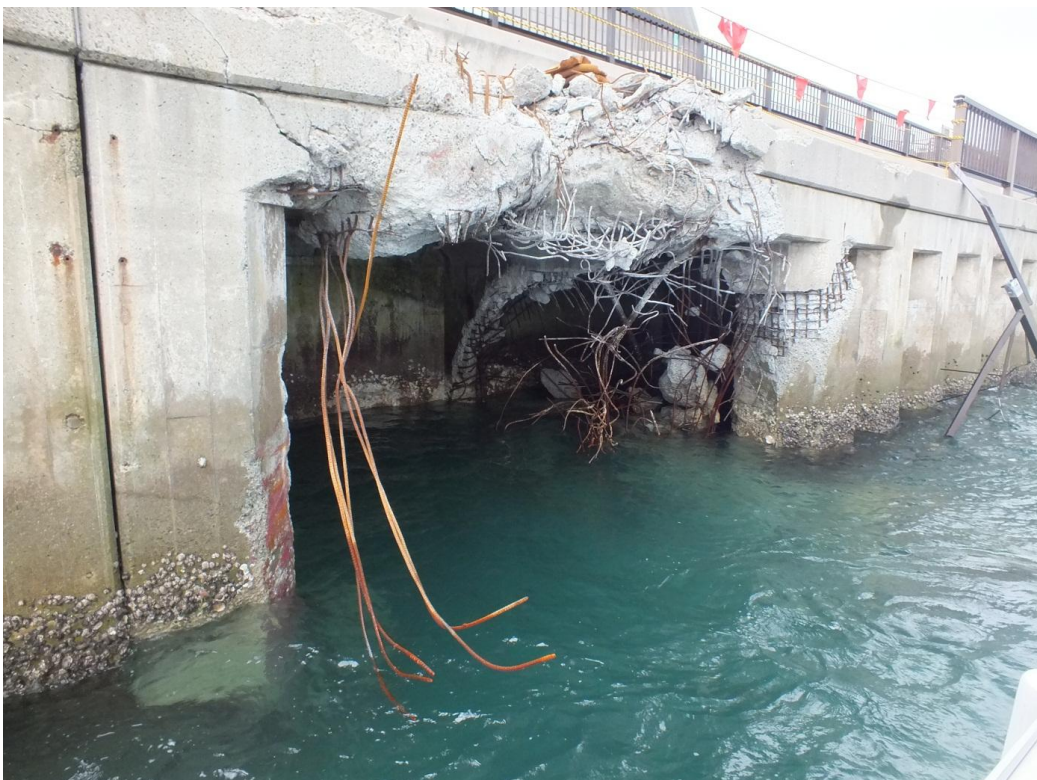
写真4 護岸損傷部
