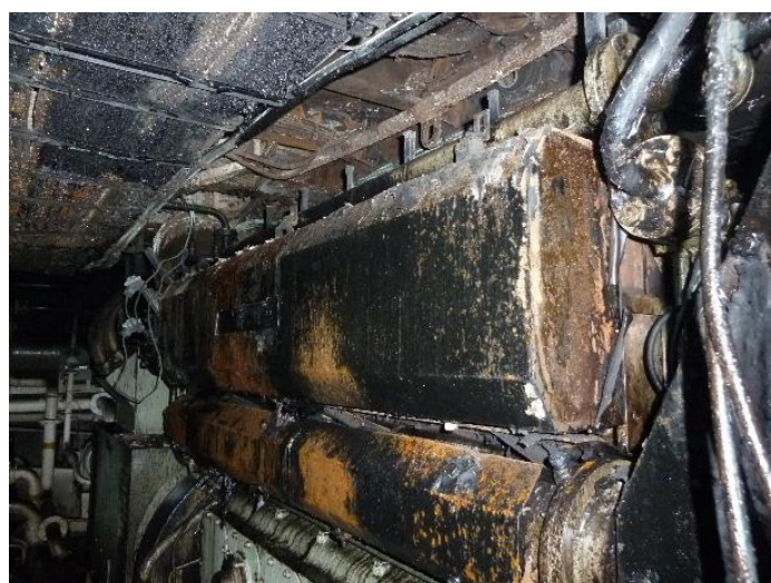
写真10 排気管カバー
