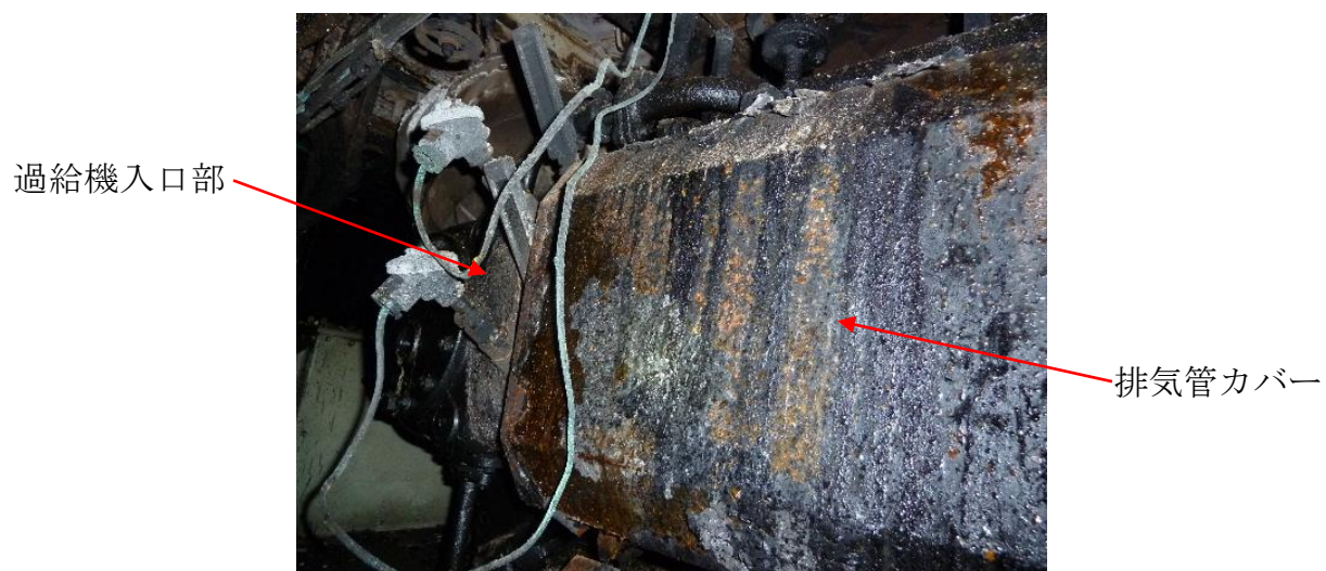
写真9 排気管カバー及び過給機入口部
