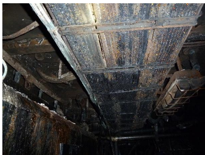
写真11 潤滑油冷却器の天井部
