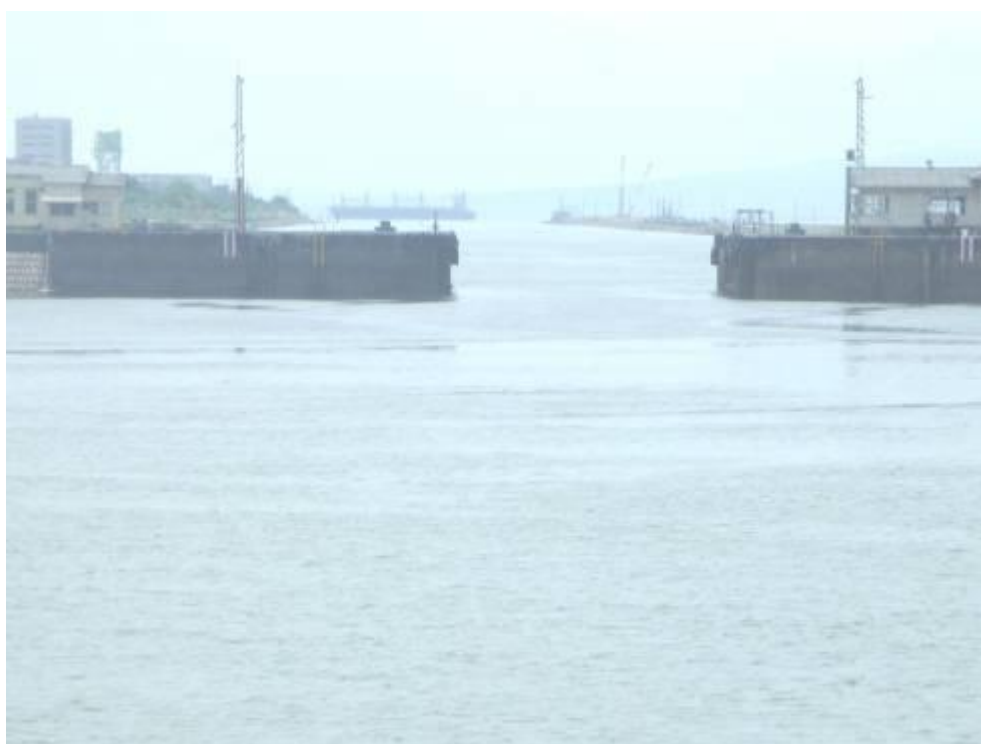
写真2 本件水門（ドック側から撮影）
