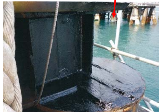
補修工事後 (平成22年6月撮影)
